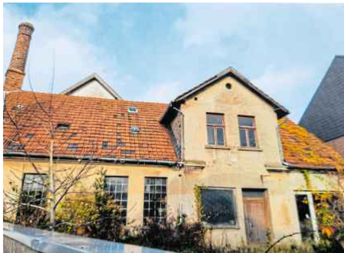
2015 wurde das Gebäude an der Herforder Straße in Bünde mit seinem markanten Schornstein abgerissen.
