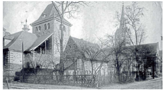
Rathaus-Richtfest mit Blick von der Elisabethstraße: Auf dem Rathausturm ist 1916 ein Richtfestbaum angebracht. Die Markthalle kann noch nicht fertiggestellt werden, das Häuschen der Witwe Beu steht noch im Weg. FOTO: GESCHICHTSVEREIN HERFORD
